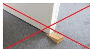
Die Türen sind daran zu erkennen, dass sie normalerweise selbst schließen (z. B. über ein Federband oder einen Türschließer) oder zusätzlich als Brand- oder Rauchschutztüren gekennzeichnet sind. Diese Türen können zusätzlich mit einer Feststellanlage ausgerüstet sein, welche die Tür dauerhaft offen hält und bei Raucheinwirkung die Tür zum selbsttätigen Schließen freigibt.
